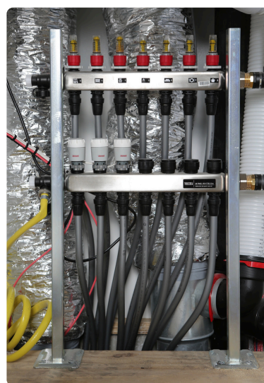
De slangen van de vloerverwarming.
