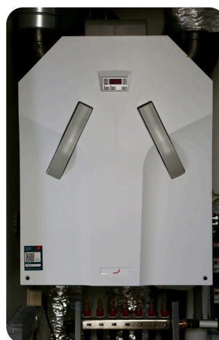
De Warmte-Terug-Win-installatie
